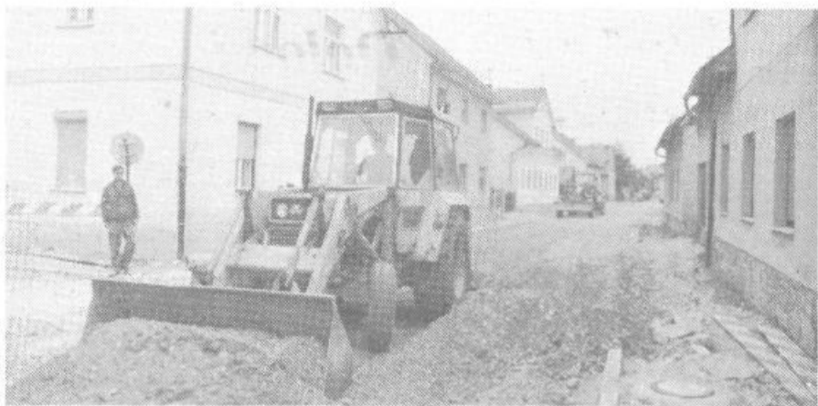
Cesta IV bo kmalu dobila asfaltno prevleko
