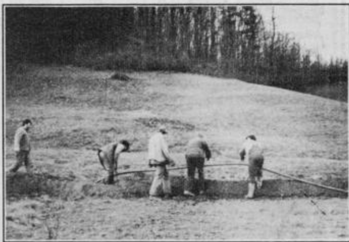
Delavci PTT Maribor polagajo v Pestikah primarno telefonsko povezavo med Zavrčem in Cirkulanami.
