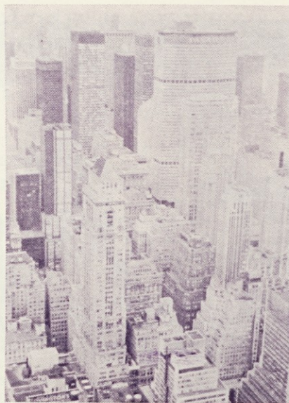
Pogled na betonsko džunglo v New Yorku
