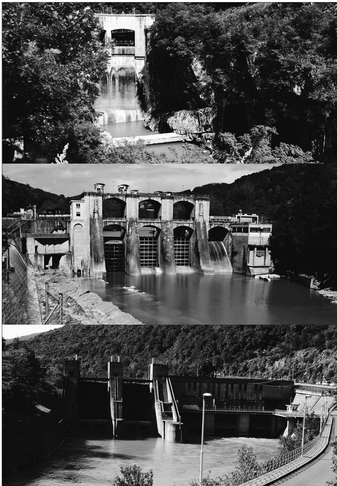
Pregrade za potrebe hidroenergetskih objektov na Soči – zgoraj: pregrada Podselja, zgrajena leta 1939 za potrebe HE Dobljar; sredina: pregrada Ajba, zgrajena leta 1940 za potrebe HE Plave; spodaj: pregrada Solkan, zgrajena leta 1984 za potrebe HE Solkan (fotograf: Matija Zorn).
