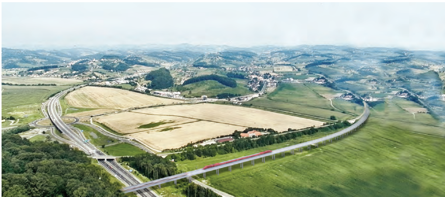
Najdaljši železniški viadukt bo stal vzhodno od obstoječega železniškega viadukta. Na južni strani bo povezan s predorom Pekel, na severni strani pa na obstoječo železniško progo pred železniško postajo Pesnica. (Foto: Ponting, d. o. o.)
