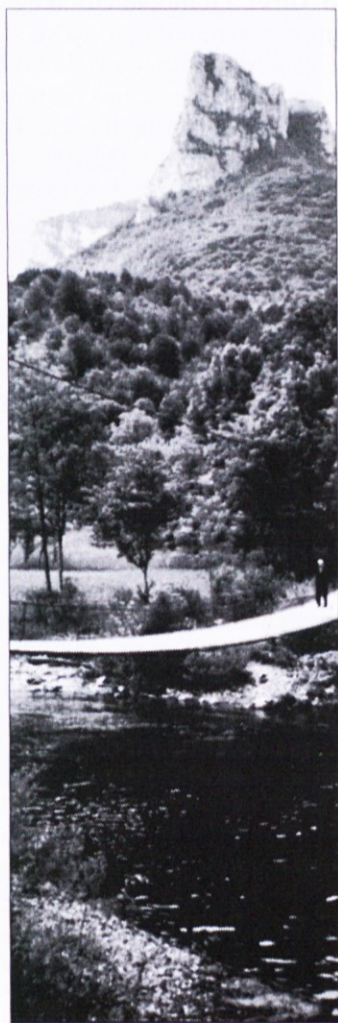
Viseči mostovi so tudi ena izmed značilnosti zgornje Kolpske doline, Gebarije. Na tem območju so trije taki mostovi preko Kolpe: v Slavskem Lazu, Srobotniku in Grintovcu, ki pa so že skoraj dotrajali, ker jih po določitvi meje nihče več ne vzdržuje.
