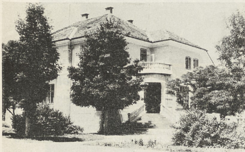
Razglednica iz Kočevja: upravna stavba PE Trgoprometa
