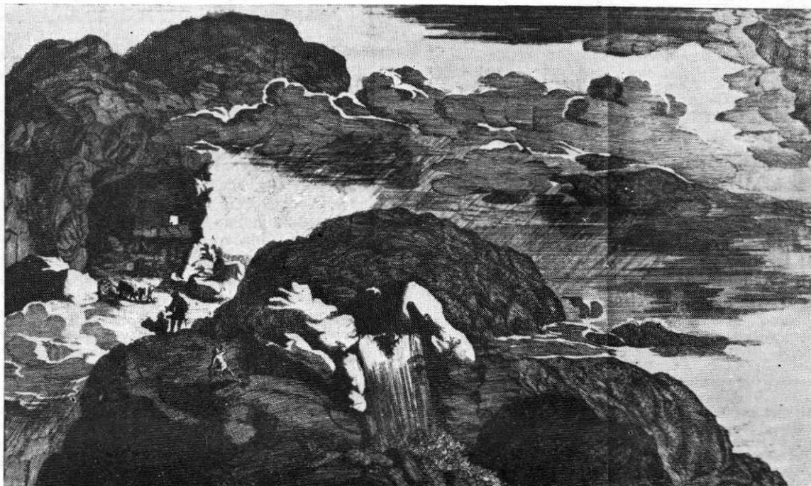
Slika 4. Ljubeljski predor s Koroške strani
