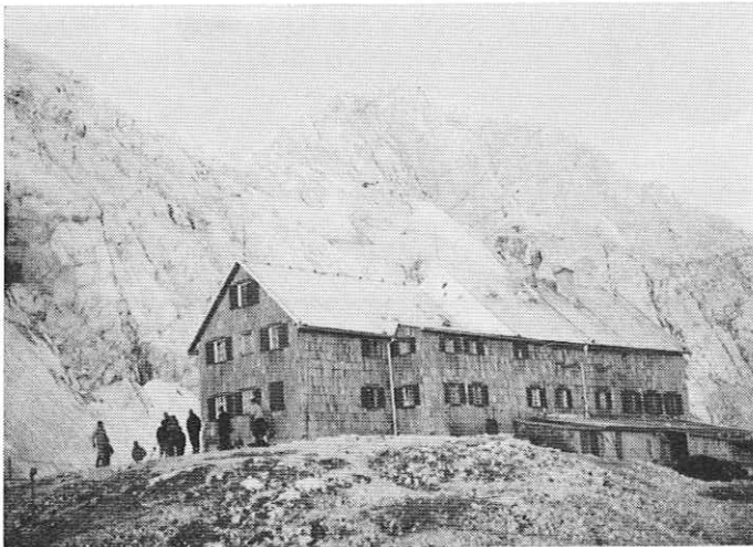
Triglavski dom na Kredarici — 2515 m — pred obnovo
