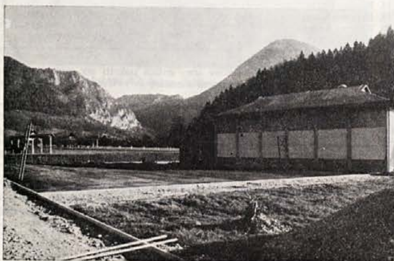
Asfaltiranje športnih igrišč ob novi begunjski šoli
