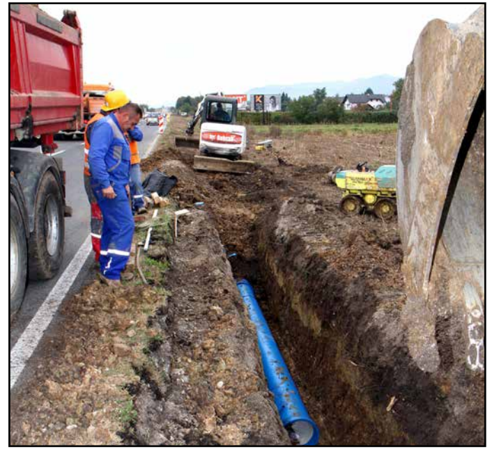
Obnova vodovoda ob žalski obvoznici
