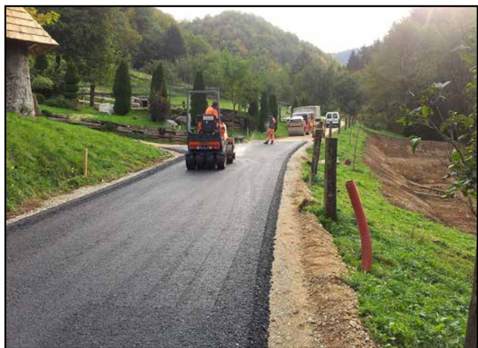
Zadnja dela na cesti pred zaključkom projekta
