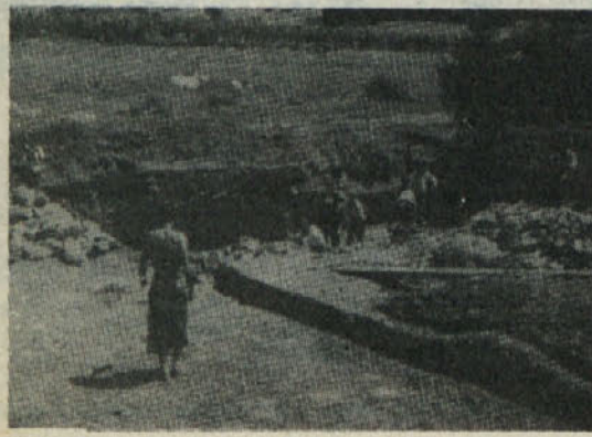
Začetek zemeljskih del (22. 6. 1937)
