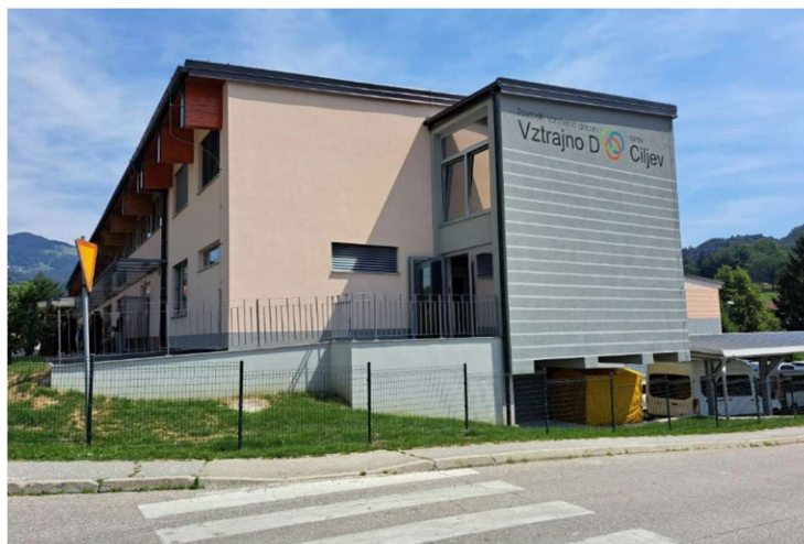
Slika 3: Stavba Varstveno delovnega centra Zagorje ob Savi (foto: osebni arhiv)
