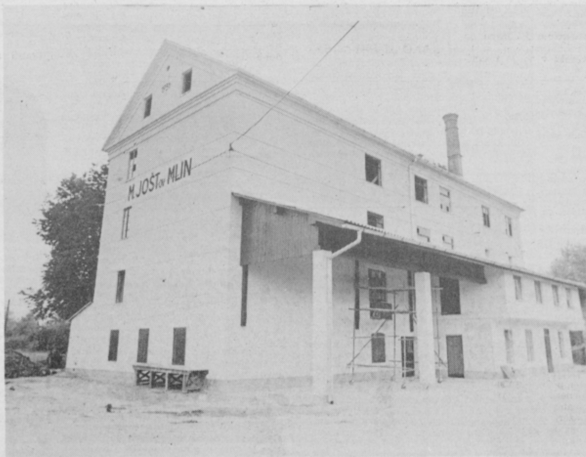
Danes je zunanost Joštovega mlina obnovljena. Napis spominja na tiste znamenite dni pred skorajšnjim začetkom druge svetovne vojne. Foto: D. M.
