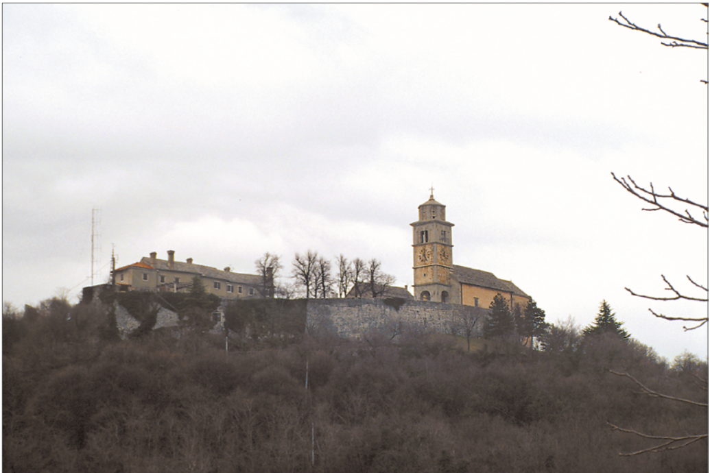
Figura 14. Un tetto ricoperto di lastre di pietra, Šmarje pri Sežani (foto A. Panjek). Figura 15. Campagna fortificata: il tabor di Monrupino/Repentabor (foto: archivio CMC).
