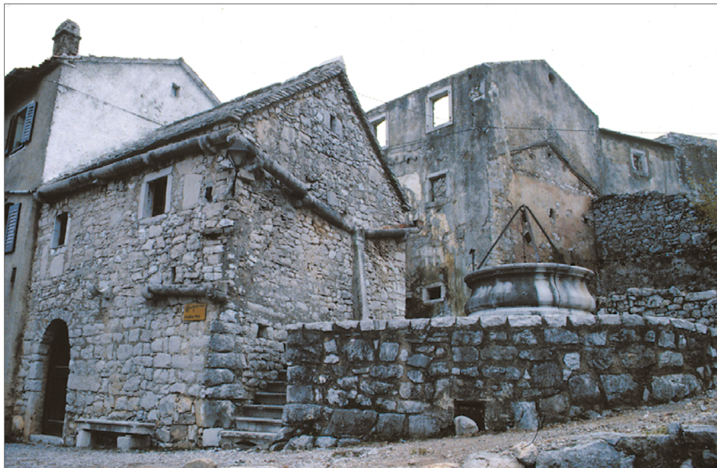
Figura 26. L'uomo e l'acqua in Carso: la raccolta dell'acqua piovana da un tetto in pietra (foto: archivio CMC).
