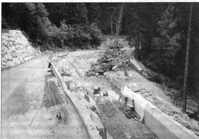
Sanacijska dela na cesti proti Pavličjevemu sedlu (foto: Savinjčan)
