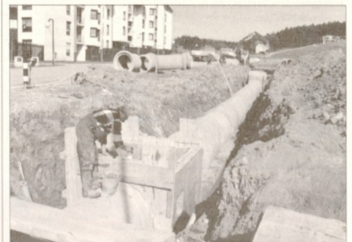
V Rabelčji vasi gradijo Nizke gradnje kanalizacijo za meteorno vodo. Foto: M. Ozmeč
