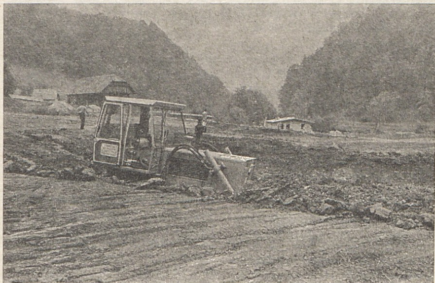
GIP Beton — Zasavje iz Zagorja ob Savi je pričelo z zemljiškimi deli za postavitve tovarne plinobetona v Kisovcu.
