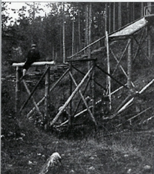
SKAKALNICA V GRADNJI, KAKRŠNO JE POSNEL FRANCİ.
