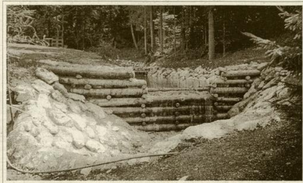
Sanacija hudournika na Kropi se lepo prilagaja naravnemu okolju.
