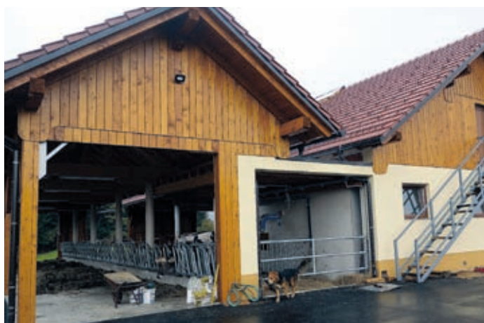
Za naložbo v nov hlev je bilo potrebnega enkrat več denarja, kot so ga Špitalovi pridobili na razpisu.
