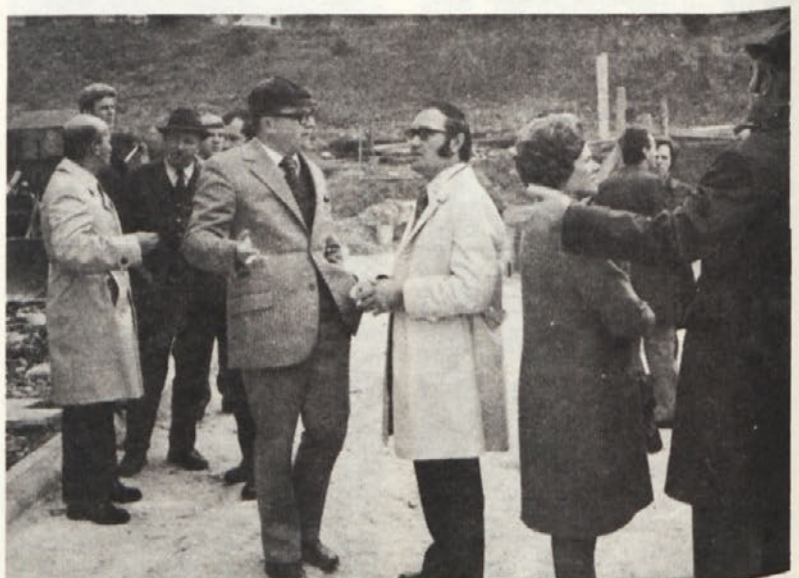
Predstavniki Krajevne skupnosti Novo mesto si pod strokovnim vodstvom gradbišča z zanimanjem ogledujejo gradnjo stanovanjske soseske Ragovska v Novem mestu
