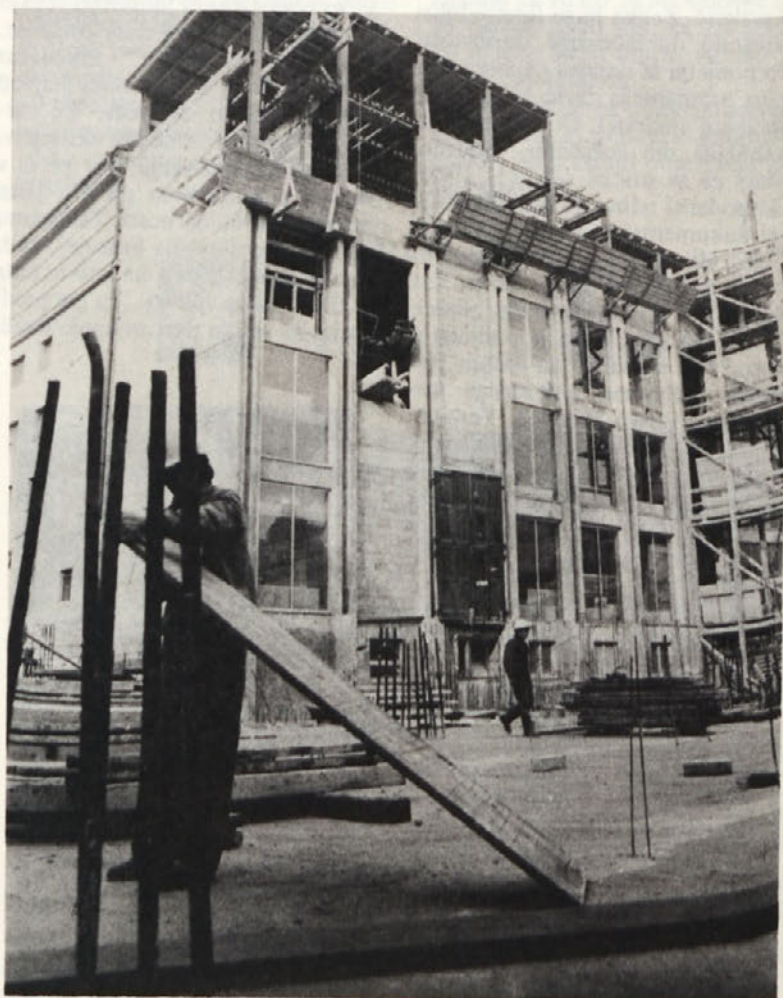
Zahtevna gradnja novih prostorov Mestnega gledališča Ljubljana, ki jo je opravil sektor Ljubljana, v stanju, kot je bila poleti 1973
