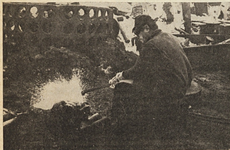
Visoko legirane materiale režemo avtogeno s praškom. Delo rezalcev je posebno zahtevno v zimskem času, saj ga opravljajo na prostem, pod žerjavno progo (Foto: E. L.)
