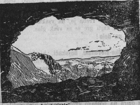
Ber Durchbruch des Jungfrautunnels.
