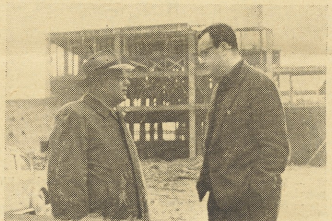
Kadar razpravljata investitor in proizvajalec. Tov. Rado Barovič in ing. Tone Pogačnik na gradbišču v Goričanah
