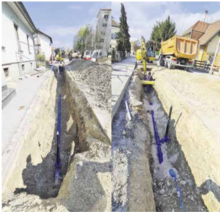
Dela na Slamnikarski cesti
