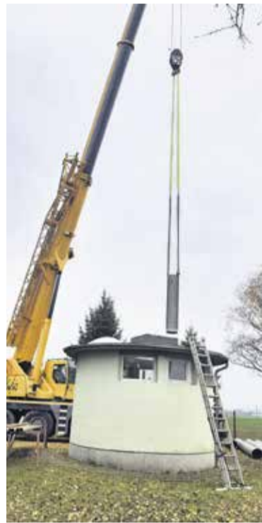
Sanacija vrtine vodnjaka Č3 na domžalsko-mengeškem polju
