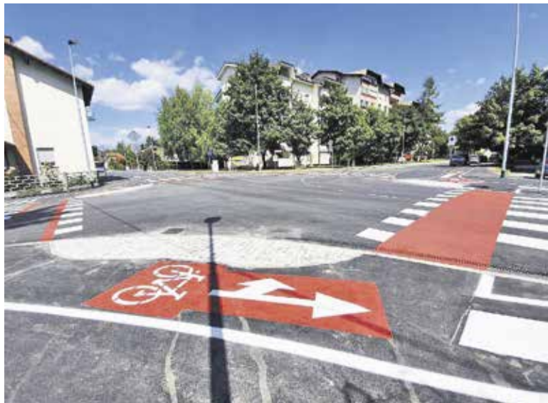
Nova in varnejša ureditev Slamnikarske ceste po zaključku investicijsko-vzdrževalnih del na vodovodu in kanalizaciji
