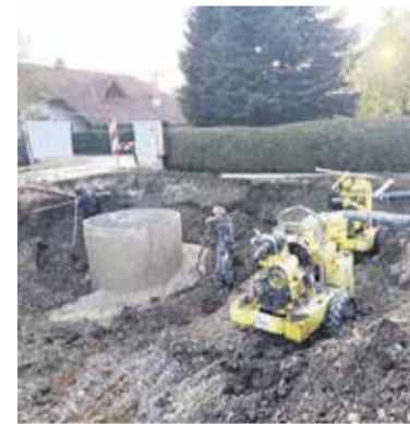
Dela na kanalizacijskem črpalnišču v Dragomlju
