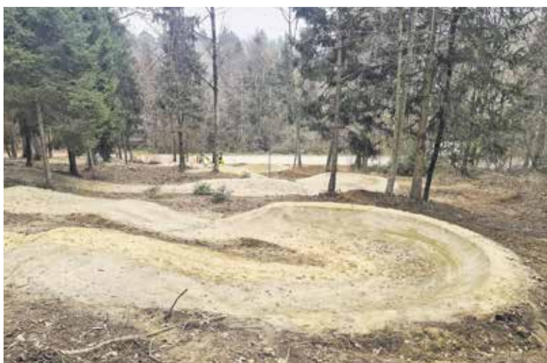
Zaključna dela na kolesarskem poligonu
