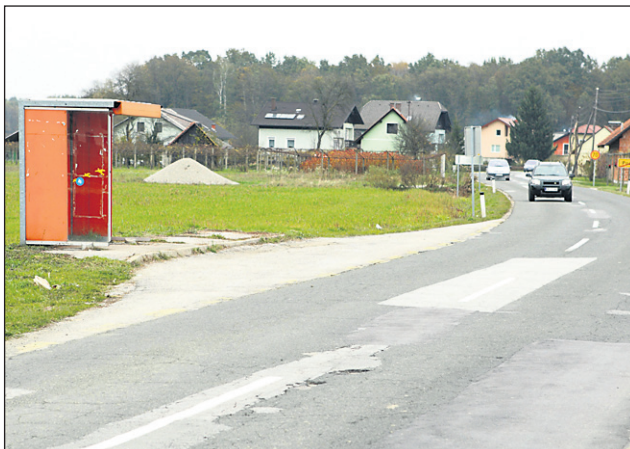
Ureditev ceste skozi Podvince v dolžini 2,3 km bo stala okrog 3,5 milijona evrov.
