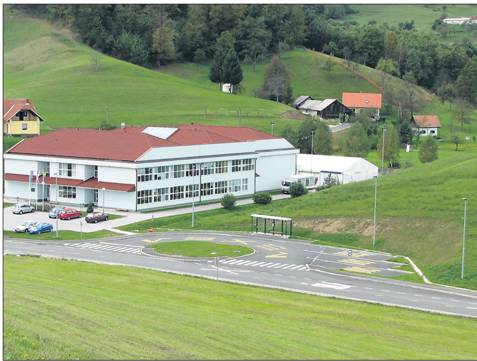
Dvoodelčni vrtec se bo gradil tik ob šoli, v vzpetini, ki je slabo osončena, zato naj bi bila po besedah projektantov in energetskih strokovnjakov gradnja še nekaj dražja.
