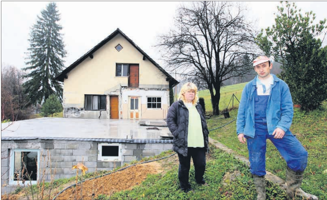
Slavica in Boris si bolj kot vse drugo želita, da bi se nekoč vrnili na domačo zemljo. Gradnjo nove hiše sta že načrtovala na mestu, kjer je postavljena garaža. Ali bo to mogoče in bo dovolj varno, bo znano v naslednjih dneh.
