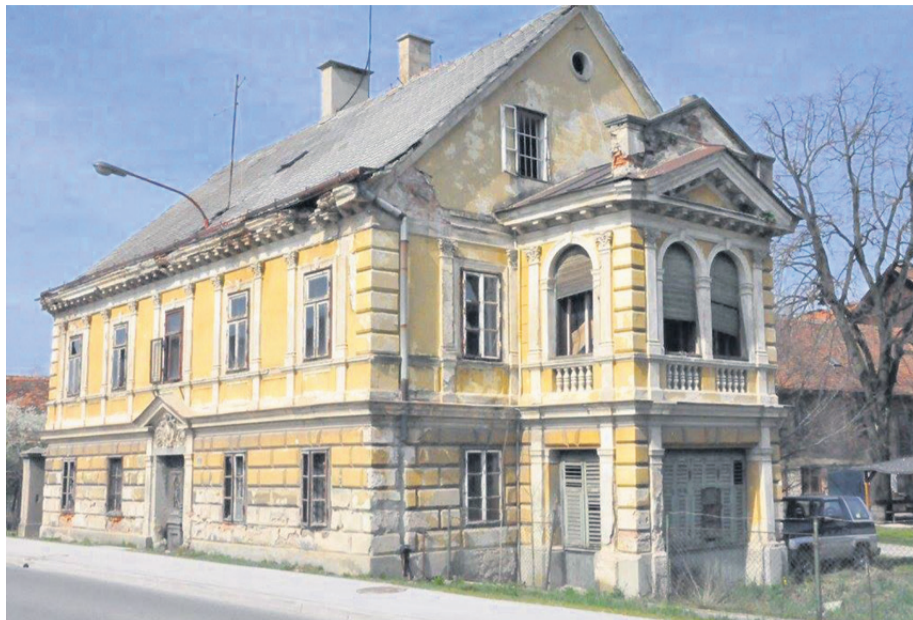
Lenkova vila. Stavbo je močno načel zob časa in obnova je bila nujna. Dolgo so se pregovarjali, kdo in na kakšen način je odgovoren za obnovo kulturnega spomenika. Ko so se lastniki vendarle odločili za obnovo, je bilo že prepozno. Del hiše se je namreč ob majhnem posegu pri obnovi strehe podrl.
