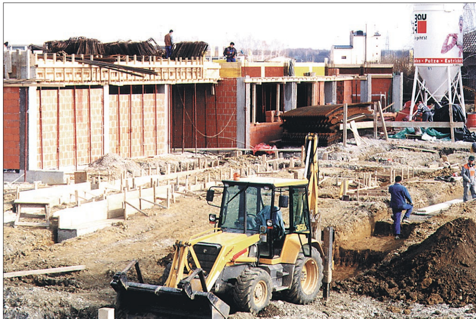
Na gradbišču gimnazije Ormož je prvi del objekta že tik pred tem, da naredijo ploščo
