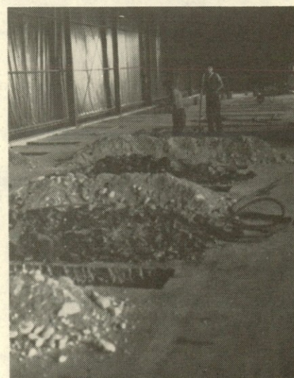
... zato delavci kranjskega Gradbinca že pripravljajo teren za novega ...
