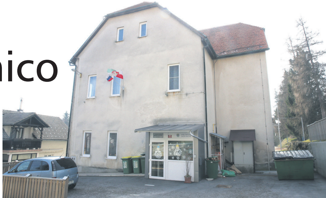
Stavba podružnične šole na Kalobju je bila zgrajena leta 1898. Med drugo svetovno vojno je bila požgana. Država je sledila oceni, da obnavljanje ni več smiselno, in prispevala večino denarja za novogradnjo.
