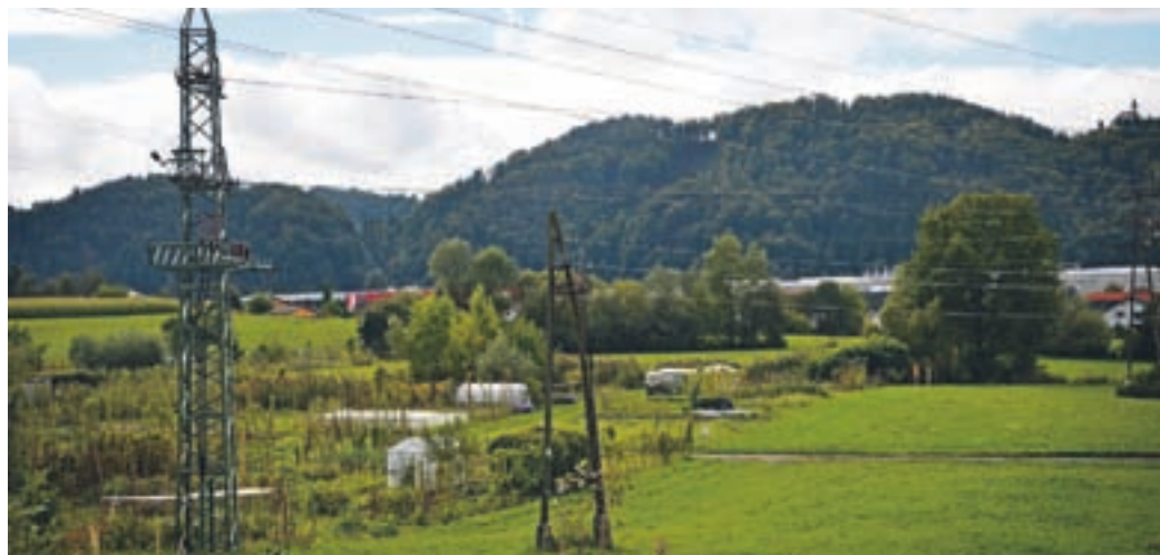
Pod staro Elektrarno bodo ukinili le tretjino vrtičkov.
