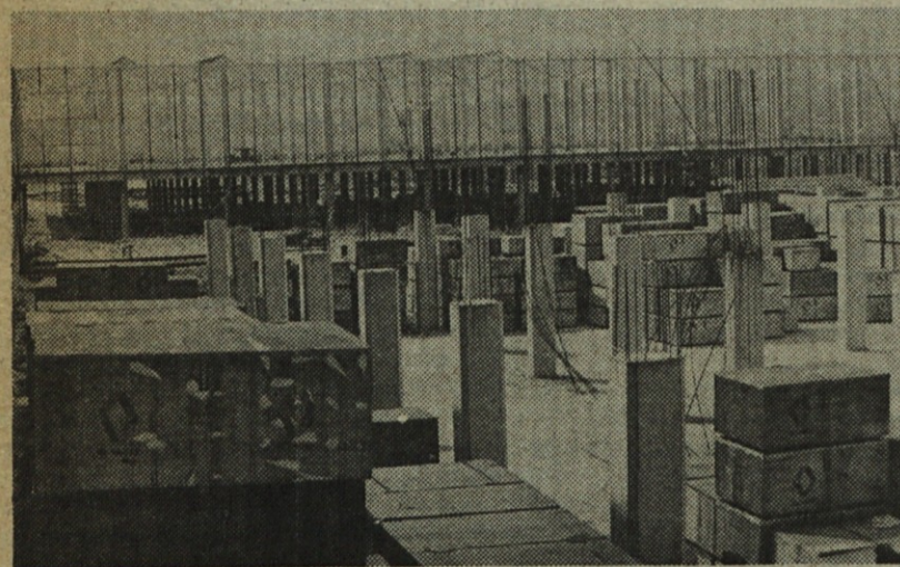
Omejevanje investicij je prizadela tako industrijo kot tudi gradbeništvo. Na sliki je nedokončani objekt za IMV iz Novega mesta, ki ga sedaj po dveletnem mirovanju ponovno gradi naš tozdr GE Ljubljana-okolica
