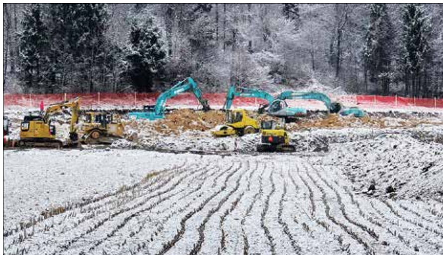
Dela za nov logistični center, ki bo velik 4.500 m 2 , na zemljišču nasproti podjetja BSH Hišni aparati Nazarje so v teku. (Foto: IS)
