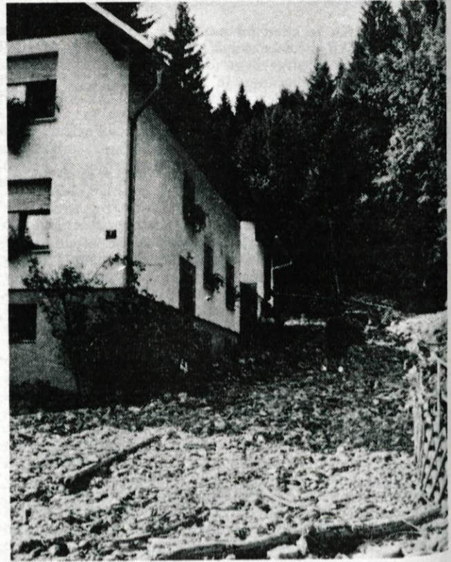
Kamenje, ki ga je zanesel plaz med hiše na Račevi.
