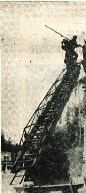
Pri montiranju novih »svetilk« so si delavci pomagali z gasilsko lestvo
