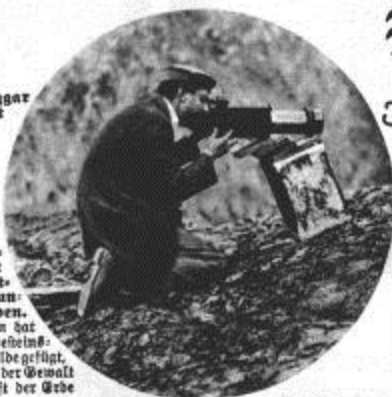
Unten: Arbeit auf einem erkalteten Teil des Lavafeldes. Hier wird ein großer Teil der Beobachtungs- geräte aufge- stellt. Über den fochenden Krater selbst wird ein Drahtseil ge- spannt, an dem später be- sonderes in- strumentelle Meß- instrumente sehr nahe über die fochende Lava gebracht werden können. Man ist dadurch in der Lage, die Ausdehnung und Druck der Eruptionen genau festzustellen. Das Drahtseil wird meistens mit einem harpunenartigen Instrument über den Lavafeld hinüber- geschoben
