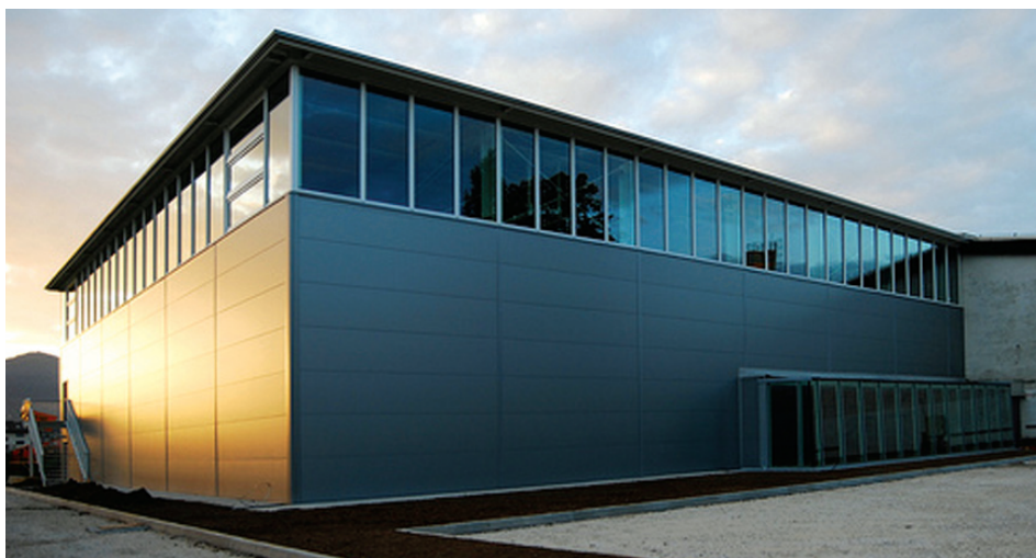
Zunanjščina nove športne dvorane pri OŠ Cvetka Golarja na Trati. (foto: Jana Jocič)
