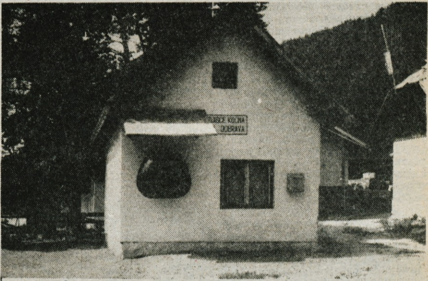
Telefonska govornilnica na Poljanah — Podjetje za PTT promet Kranj, ki razpolaga z znatno manj sredstvi za izgradnjo krajevnih telefonskih mrež, se je odločilo, da postavi več javnih telefonskih govornilnic. Med drugim so jo namestili tudi na Kočni na Poljanah nad Jesenicami. — Foto: D. Sedej
