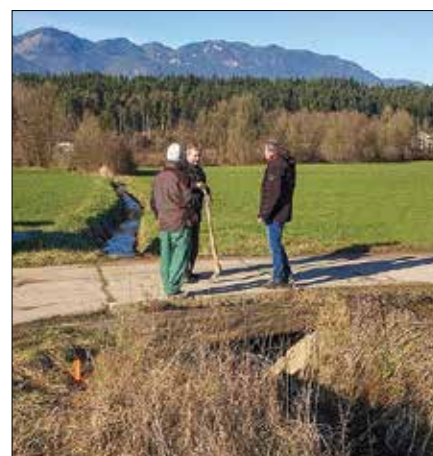
Ogled na terenu in priprava za zamenjavo preozkega prepusta (fotodokumentacija Občine Nazarje)
