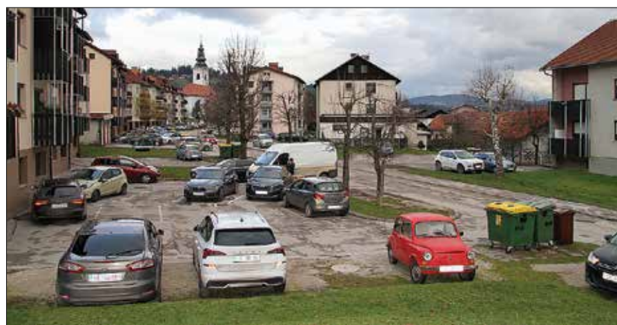
V Mozirju bodo obnovili infrastrukturo na območju Praprotnikove in v delu Aškerčeve ulice.
