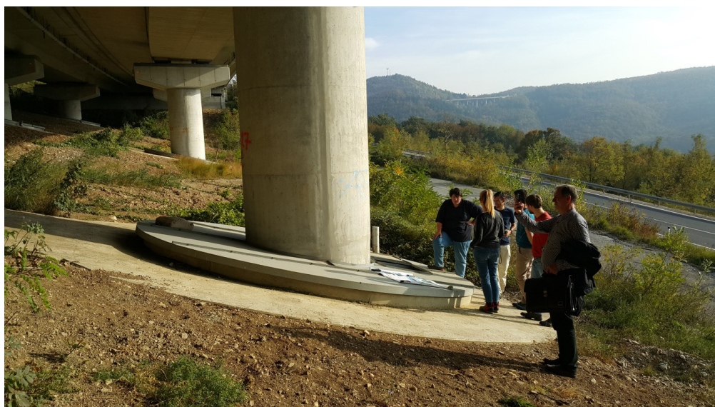
Sl. 2. Viadukt Podboršt, točka na študijski ekskurziji »Plazovi v Vipavski dolini«.
