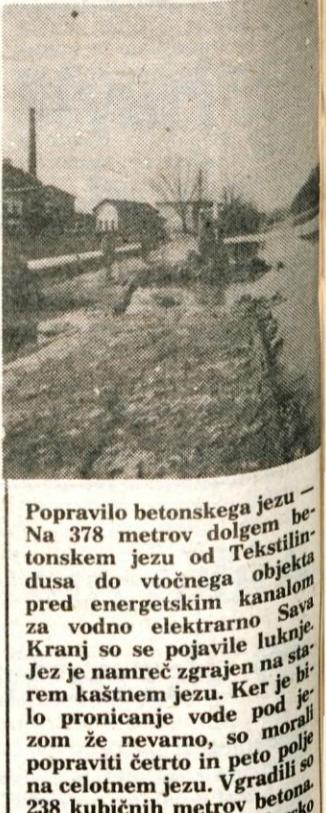
Popravilo betonskega jezu — Na 378 metrov dolgem betonskem jezu od Tekstilindusa do vtočnega objekta pred energetskim kanalom za vodno elektrarno Sava Kranj se je pojavil luknjek. Jez je namreč zgrajen na starem kaštnem jezu. Ker je bil pravno pronicanje vode pod jezom že nevarno, so morali popraviti četrto in peto polje na celotnem jezu. Vgradilo je 238 kubičnih metrov betona. Delalo je Vodnogospodarsko podjetje Kranj.
