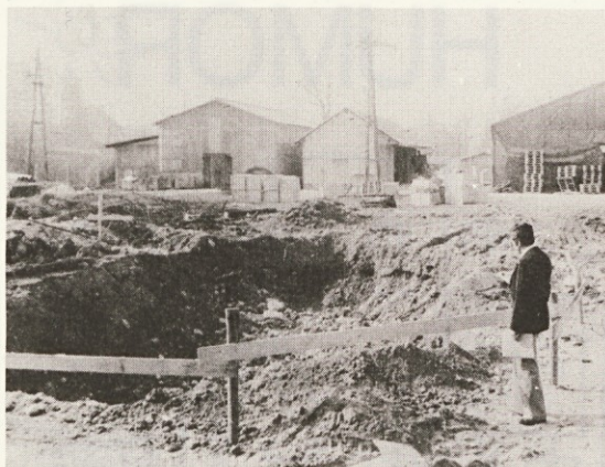
V ZAČETKU JE BILO POTREBN PRIPRAVITI TEREN. POSEK IN ODSTRANITEV DREVJA SMO ZAUPALI ZUNANJEMU IZVAJALCU. POTE M PA SE JE ZAČELO Z IZKOPOM GRADBENE JAME ZA OPLEMENITILNICO.
