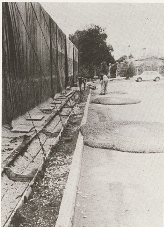
OB KORIDORJU SMO NAJPREJ POLOŽILI PLASTIČNE CEVI ZA ODPADNE TEHNOLOŠKE VODE IN ODTOČNE KANALE ZA METEORNE VODE KORIDORJA. NA SLIKI VIDIMO DVA DELAVCA PRI BETONIRANJU MULDE.
