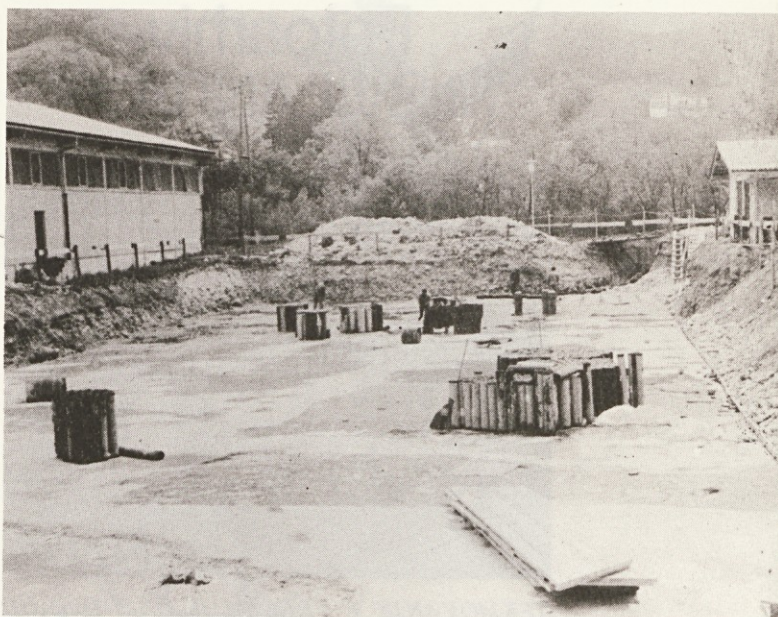
PO IZKOPU SO ZABETONIRALI PODLOŽNO PLOŠČO IN NANJO NAVOZILI IZOLATERSKI MATERIAL.
