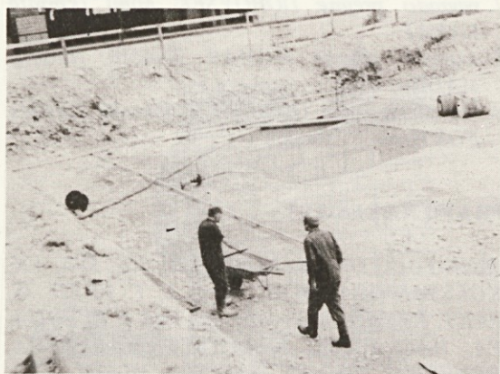
PRI GRADBENIH DELIH NAM OD VSEGA ZAČETKA NAGAJA VODA, TAKO TALNA VODA KOT TUDI VISOKI NIVO BISTRICE ZARADI POGOSTEGA DEŽEVJA. NA SLIKI VIDIMO DVA DELAVCA OD „GRADITELJA“, V BLIŽINI PA JE Z VODO ZALITA JAMA ZA JAŠEK DVIGALA.
