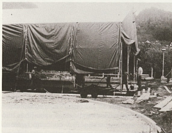
ASFALTERJI SLOVENIJE CEST PRI POLAGANJU ASFALTA V PODALJŠKU ŠOTORA.
