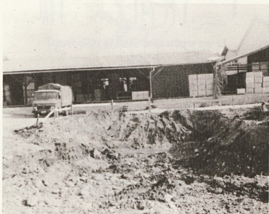
PO IZKOPU GRADBENE JAME SO SE MORALI ŠOFERJI S SVOJIMI TOVORNJAKI ZA NEKAJ ČASA POSLOVITI OD RAMPE.
