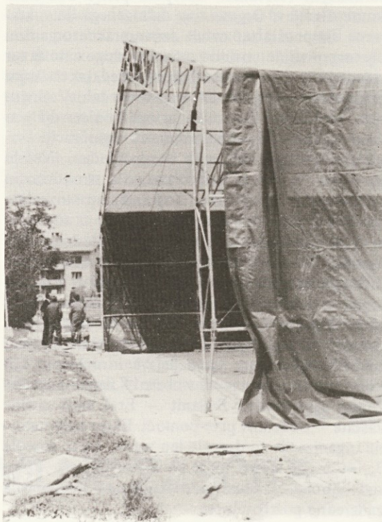
MONTERJI IZ INDUPLATI JARŠE SO POSTAVILI OGRODJE PODALJŠKA IN GA PREKRILI Z INTEGRIRANIM ŠOTORSKIM PLATNOM.
