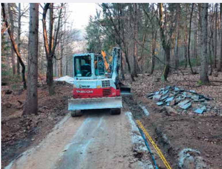
Izvajanje del na območju Brstnika.
