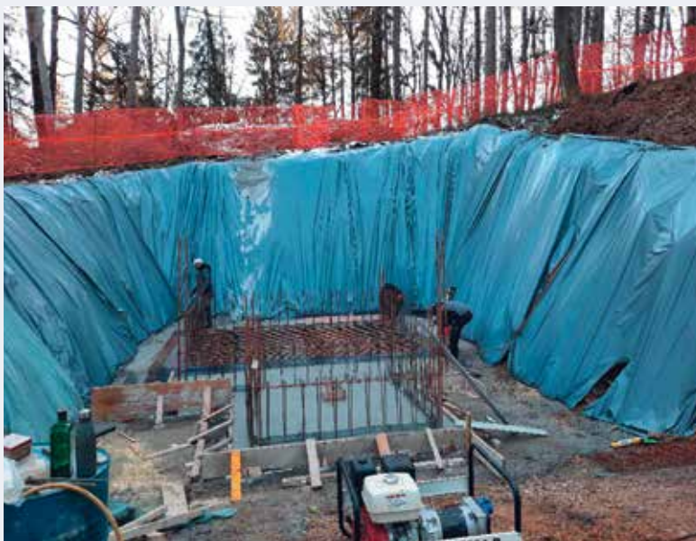
Izvajanje zemeljskih, opažnih in betonskih del na 30 m 3 VH Zahum
