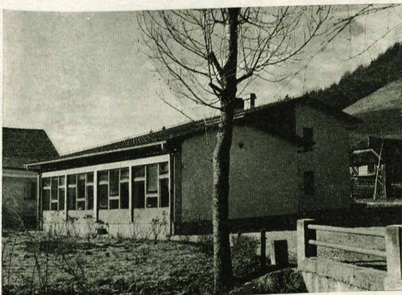
Podružnična šola v Blagovici, ki je bila zgrajena s sredstvi samoprispevka
