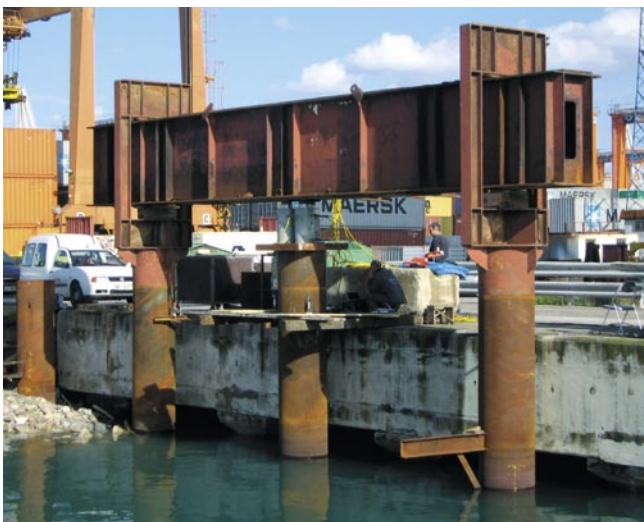
Slika 14 • Izvedba statičnega testa na pilotu D44
