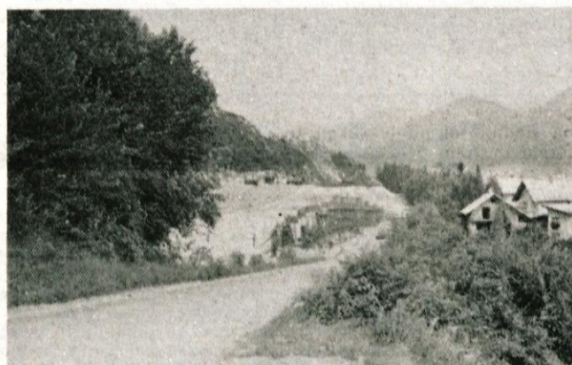
Na Lipcah zidajo varovalni zid, ki bo ločil naselje pred avtocesto
