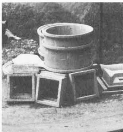
Costruzione della rete fognaria a Drenchia
