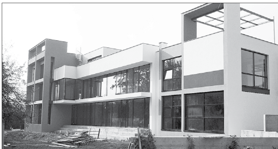
Stavba na Mozirskih tratih kljub lepim načrtom še vedno sameva. (Foto: Miran Uratnik)
